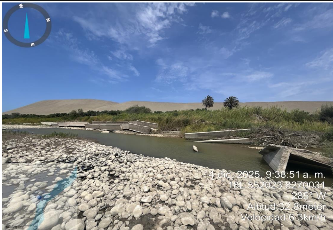
FIGURA N°01: Infraestructura hidraulica afectado por la avenida del rio Yauca: Canal principal de la COMISION DEL SUB SECTOR HIDRAULICO YAUCA
