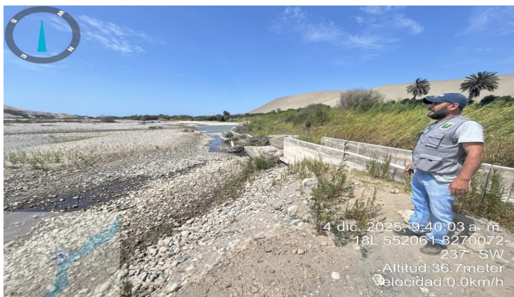
FIGURA N°03: CANAL AFECTADO POR LA EROSION DEL SUELO DE FUNDACION, DISTRITO DE YAUCA, PROVINCIA DE CARAVELI, DEPARTAMENTO DE AREQUIPA
